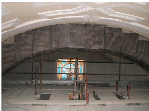
4) Arco principale sull'Altare, rimossi fregi e decorazioni è stato rivestito da fibre di carbonio per formare un unico corpo
