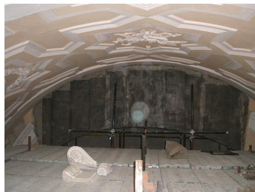
6) Arco posto sotto la cantoria, anch'esso rivestito da fibre di carbonio per formare un unico corpo
